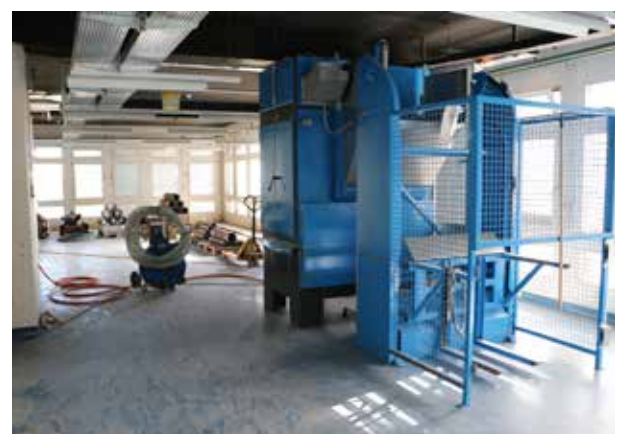
La buanderie est aussi actuellement en travaux
