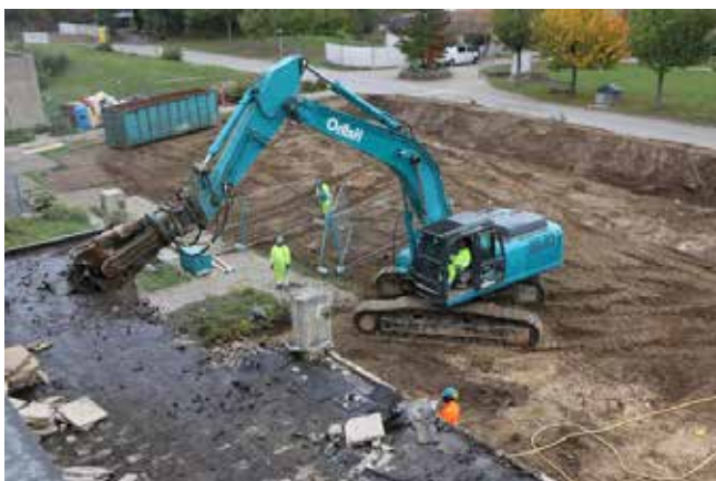
Démolition de la terrasse de la cafétéria de Lavigny
